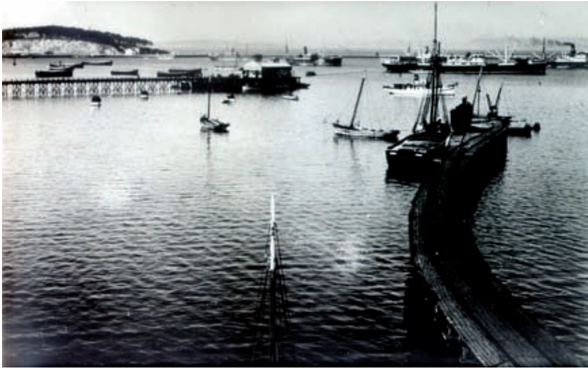
Antiguo Muelle del Ramal, con el Muelle de Hierro al fondo
