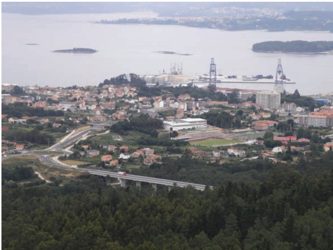
Enlace con autopista
